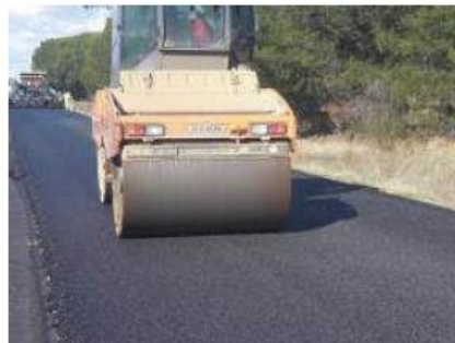
Foto 10. Compactado mezcla templada
