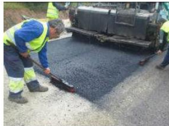
Foto 10. Operación de fresado y reposición con MBT cerrada
