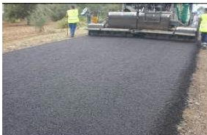
Foto 10. Extendido mezcla templada cerrada
